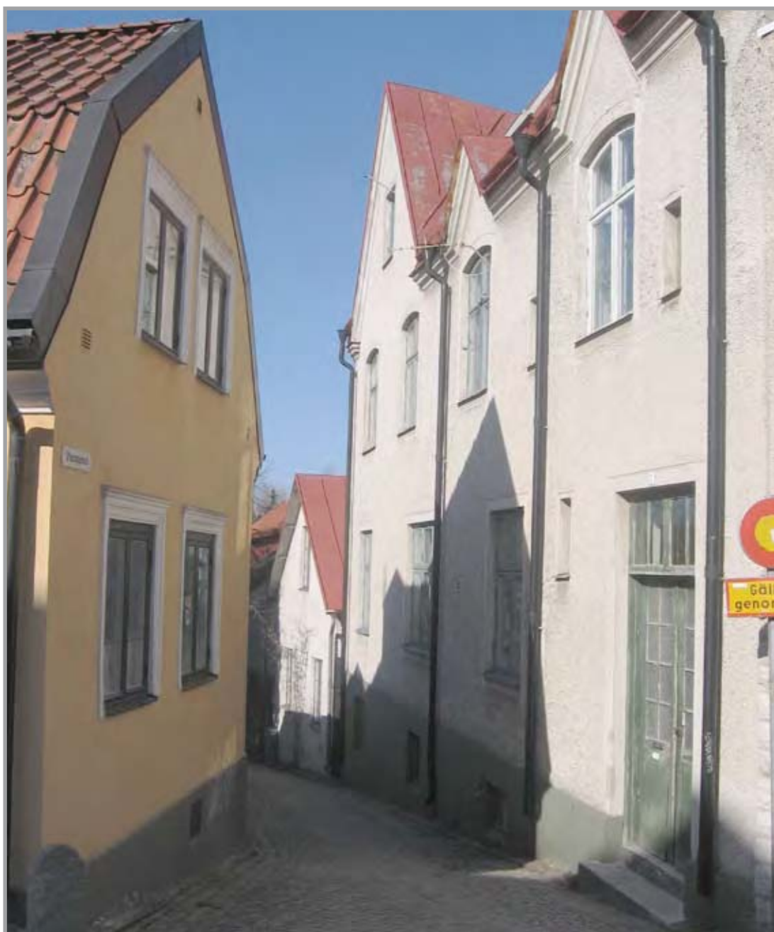
Avstånd mellan hus <4 meter.
