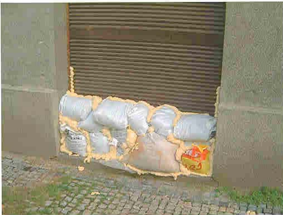
Tätning med fogskum. Foto: David Norlin.
