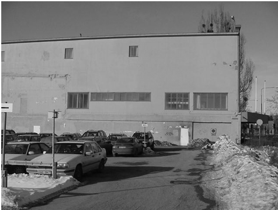
Figur 5. Bild av byggnaden som användes vid försök 4. Angeppsväg genom dörr i högra delen av byggnaden.
