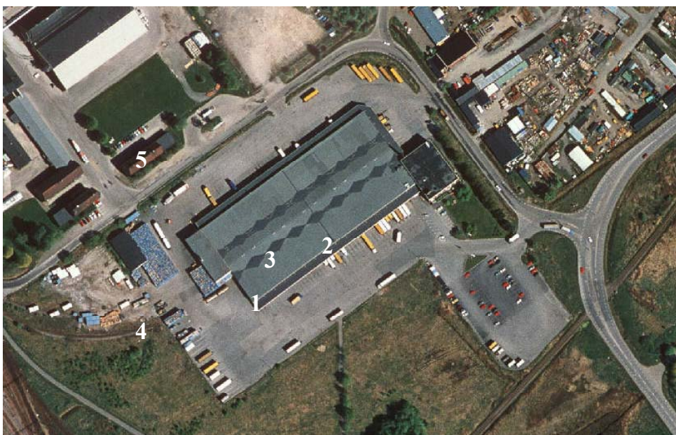
Bild 4. Områden som uppvisade strålningsskador vid branden. 1 = Glasullisolering i dörrkarm smälter. 2= Vädertätningarna skadade. 3 = Området för pyrolys av takpapp. 4 = Placering av järnvägsvagnar. 5 = Hydro Agri:s kontor.
