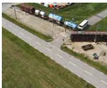
Fig. 10. Översikt av skadeplats
