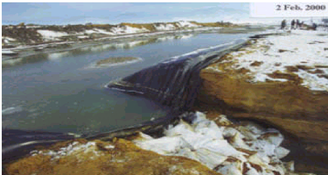
Figur 4.5 Genombrott i sedimentationsdamm. Baia Mare, Rumänien.
