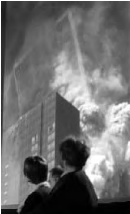
Bild 4. Den övre delen av den södra tornbyggnaden tippade mot det skadade hörnet.
