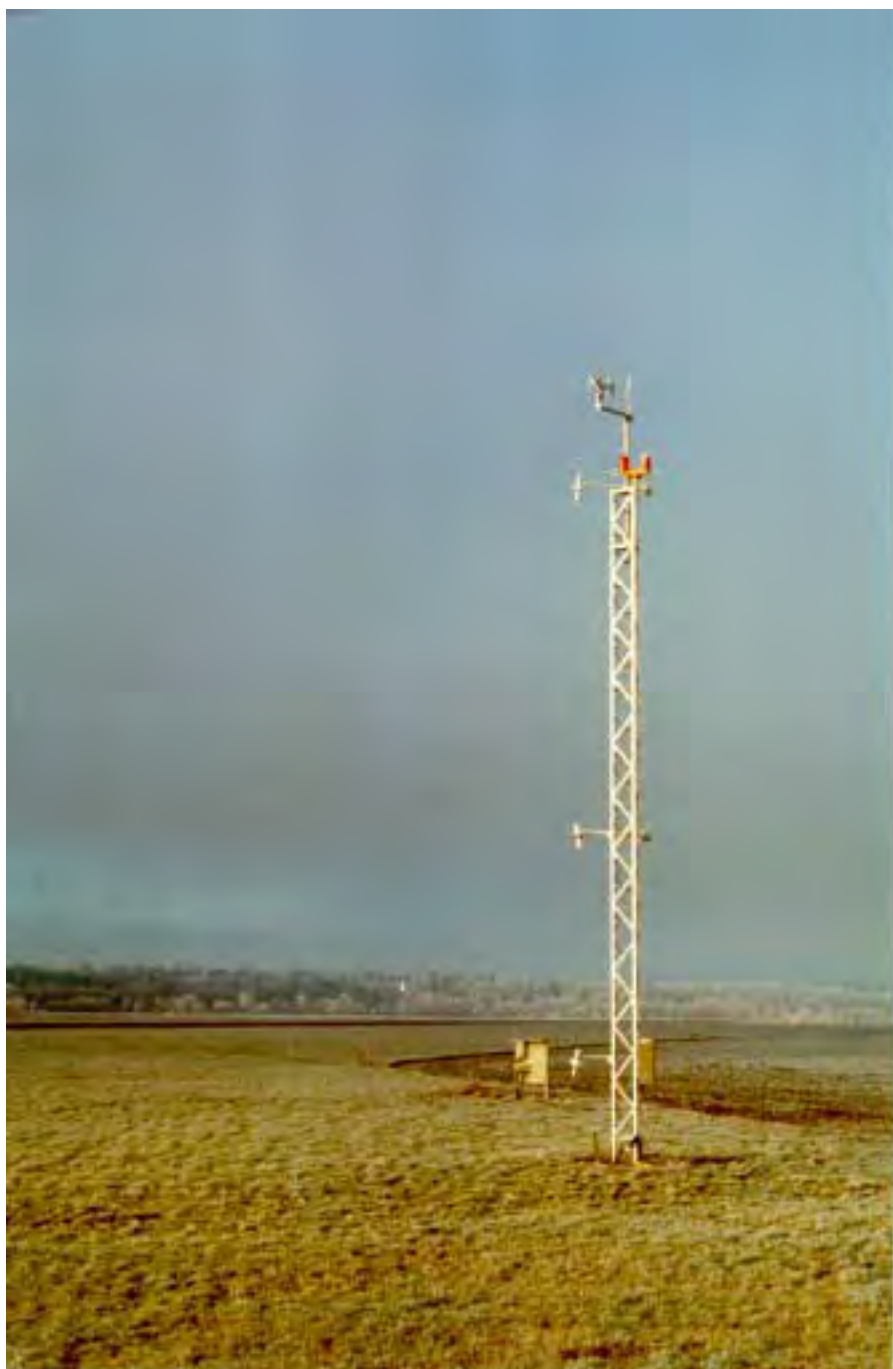
Figure 2. Mast med vind, vindriktning och temperaturmätningar
