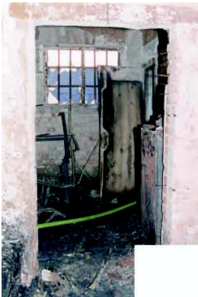
Figur 1 a. Nödutgång mot trapphuset
