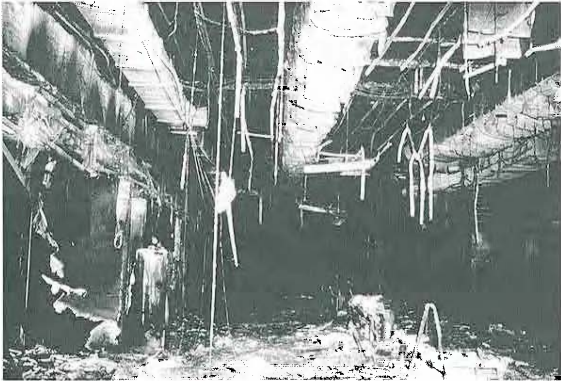
Bild 10 Total förödelse i ankomsthallen. Inget brännbart material återstår. Foto: Olle Johansson
