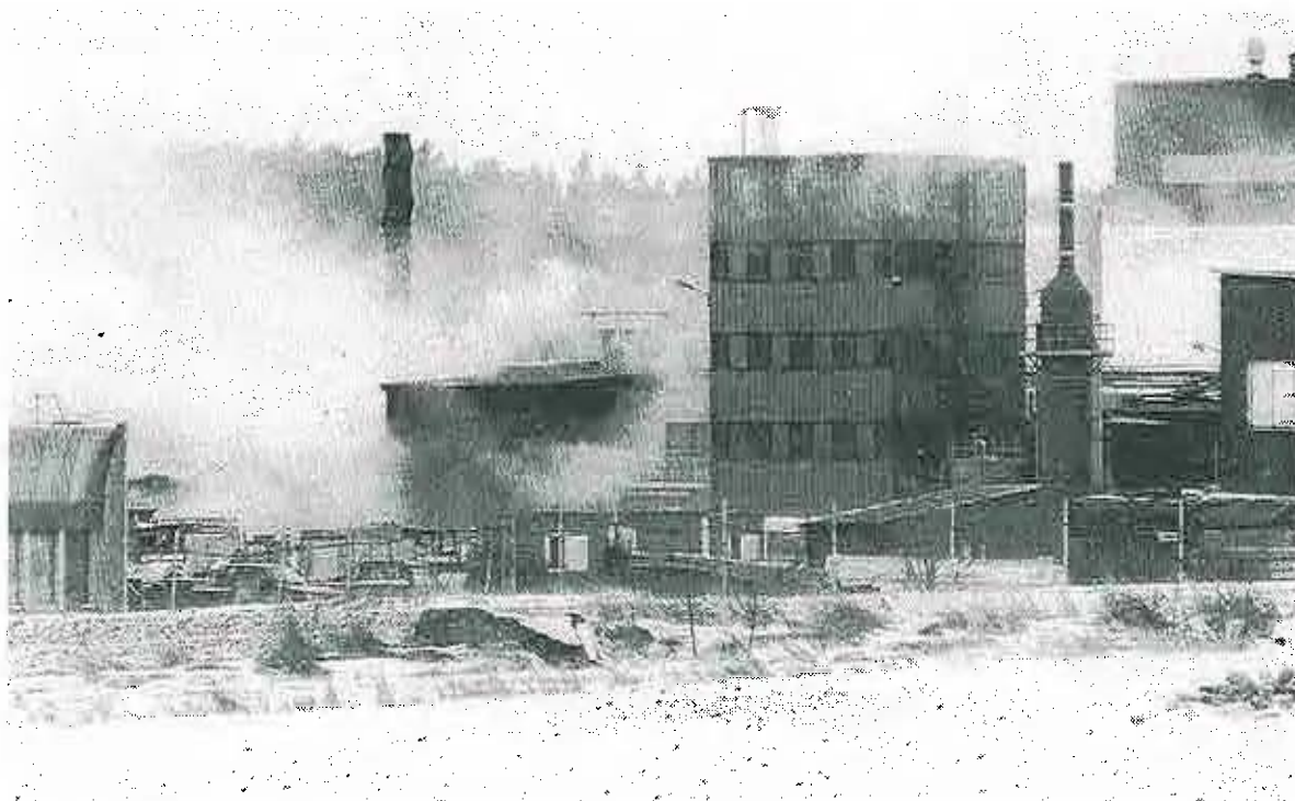
Ledningsplatsen låg bara ett femtiotal meter från skadeområdet men i lovart om det farliga gasmolnet
