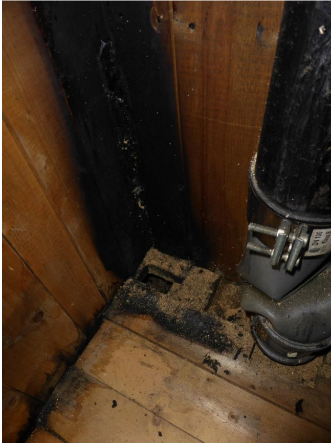
Bild 5 Luftningskanal för avlopp som mjuknat.
