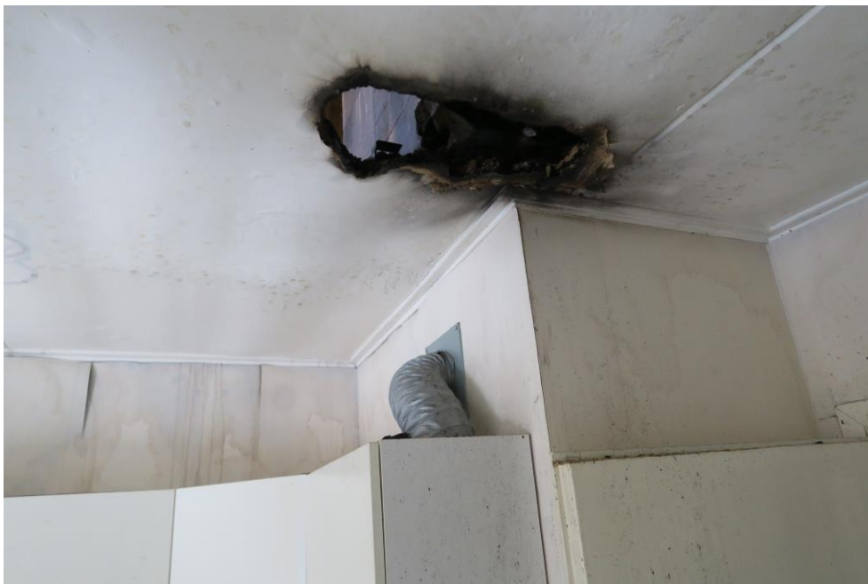
Bild 6 Genombränning till plan 3.
