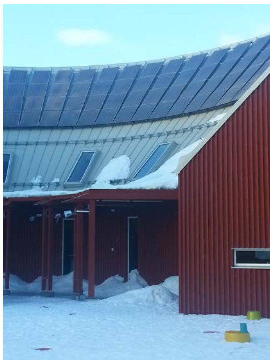
Exempel på en solcellsanläggning
