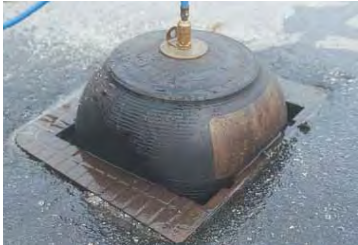
Tätning av avloppsbrunn med tätningsskudde.
