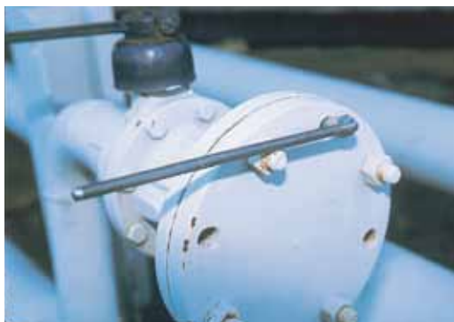
Bult med armeringsjärn underlättar åtdragningen.
