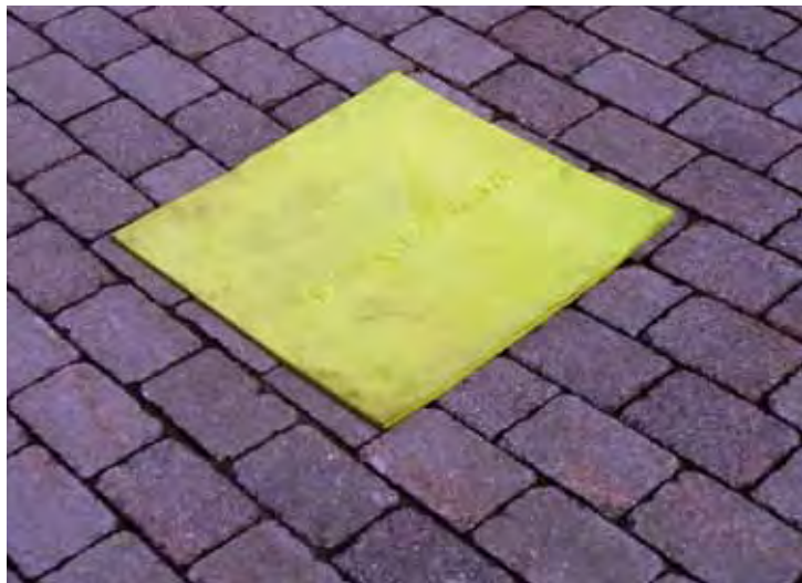
Täckning och tätning av avloppsbrunn.
