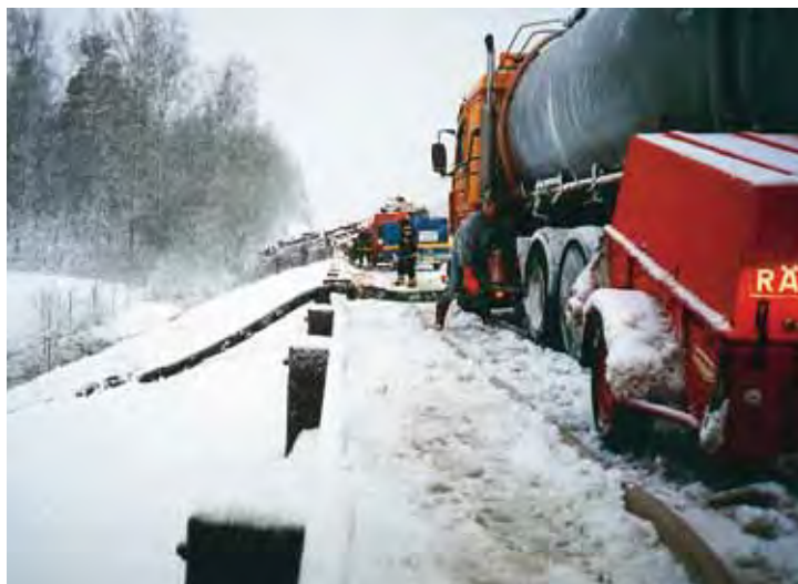
Direkt påföring av mald kalk.
