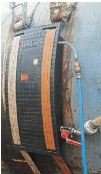
Uppsamlingskudde förankrad med lastspännare, längst ner till höger syns en kulventil och formstyv slang.
