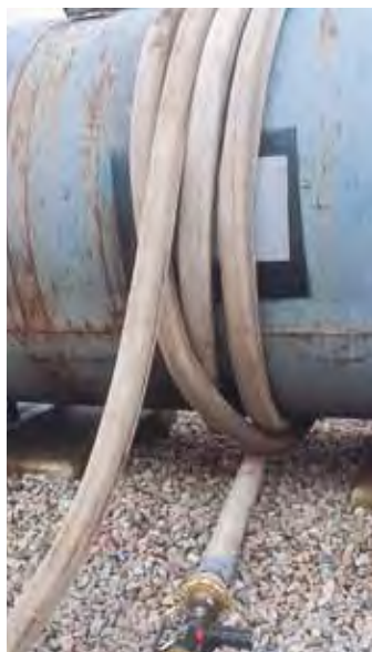
Tätning med neoprengummi, plåt-skiva och vattenfylld grovslang.
