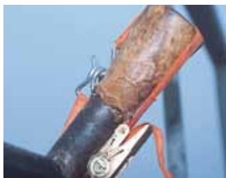
Tätning med kil, förstärkt med spännband.
