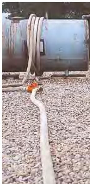
Grovslangstättning med anslutet grenrör.
