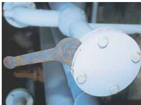
Tätning av fläns med flänsspatel.
