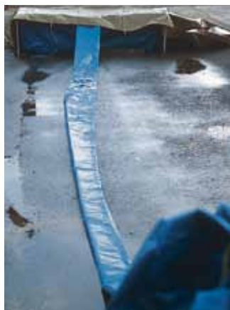
Impaktering med tratt och uppsamling i en övertäckt bassäng.
