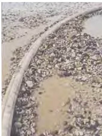
Vattenfylld grovslang som har förankrats med grus.
