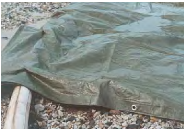
Invallning med hjälp av presenning och grovslang.
