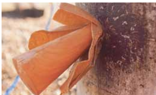
Tråkil och tätningstejp, tätningstejpen ska vikas över kilens spets.
