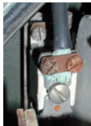
Bild 37. En anslutning där en glappkontakt eller ett avbrott har uppstått. Ledaren är en PEN-ledare där kopplingen har börjat rosta och ledaren börjat ärga.
