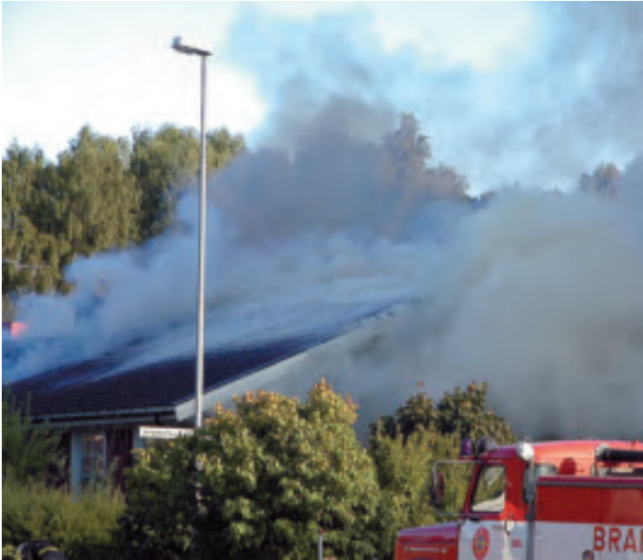
Bild 30. En ventilationskontrollerad brand.
