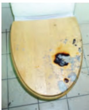
Bild 97. Toaletten i badrummet. En av lamporna i spotlightsen hade lossnat och ramlat ner på toalettstolen.
