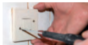
Byta en strömbrytare.
