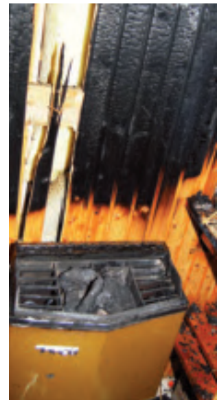
Bild 84. Bastuaggregatet där branden började.
