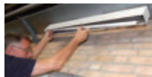
Byta ett lysrör.
