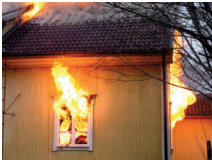
Bild 28. En fullt utvecklad brand i en villa. Lågor slår ut genom den övre delen av fönstret medan luft sugts in genom den nedre delen.
