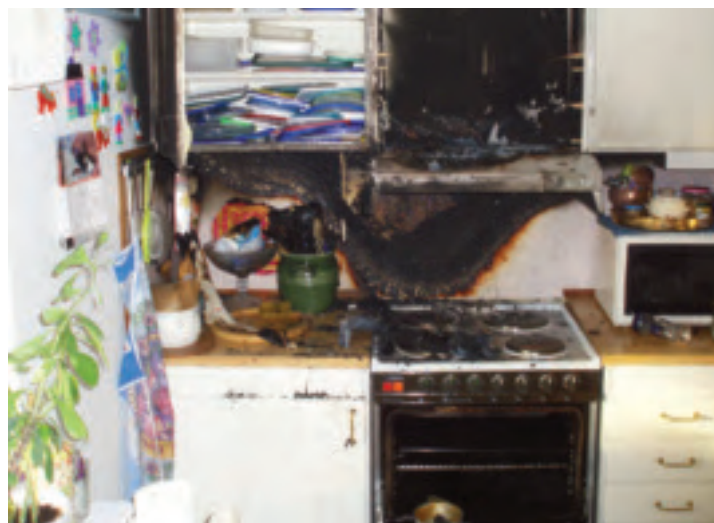
Bild 140. Ett tydligt brand-V syns på bilden efter en brand på spisen.
