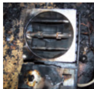
Bild 94. Sollampan som legat mot golvet. I nedre högra hörnet syns på brytarna att lampan varit påslagen samt att den varit tillslagen i IR-läge, värmeläge. Effekten var på cirka 300 W.
