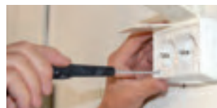
Byta ett vägguttag.
