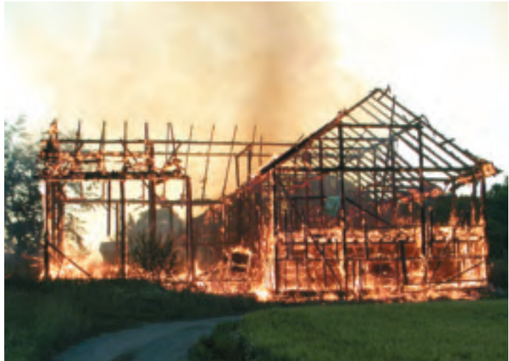
Bild 29. En brand som börjat avta i en byggnad.
