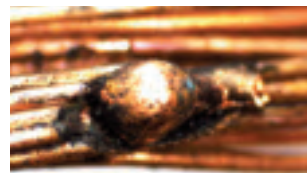
Bild 58. Kortslutningsskada på en ledare.
