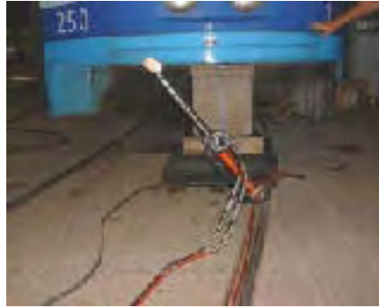
Bändare används för att kompensera lyft vid banvallen
