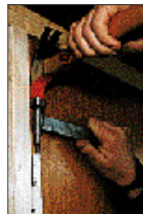
Gångjärn med löstagbara sprintar finns i regel i äldre dörrar. Då är det lätt att slå ur sprintarna och sedan haka av dörren i bakkant.
