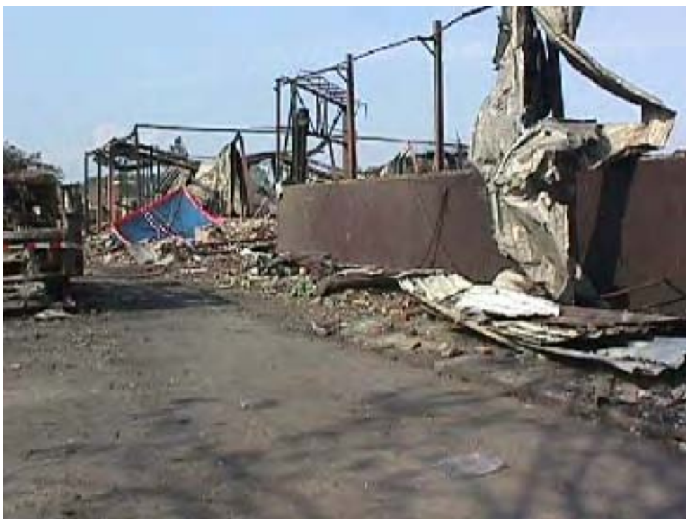
Bilden visar vad som varit porten in till företaget van Fireworks. Till vänster syns en av de två brandfordonen som blev förstörd i samband med explosionen. FOTO: HENK DERKSEN
