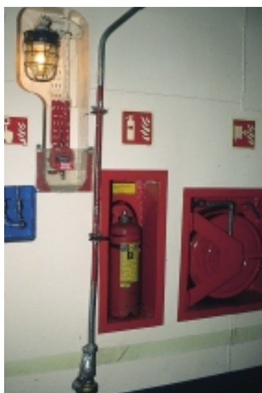
Manuell släckutrustning på bildäck
