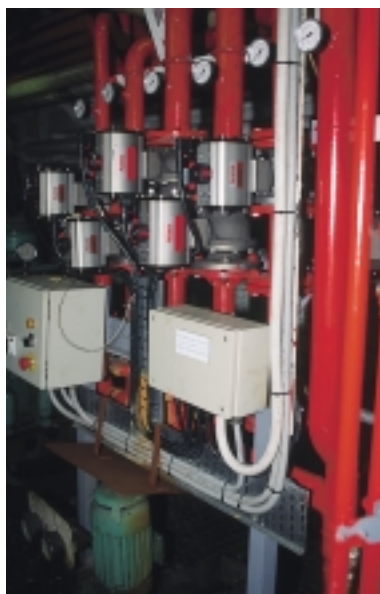
Vattensprinklercentral
