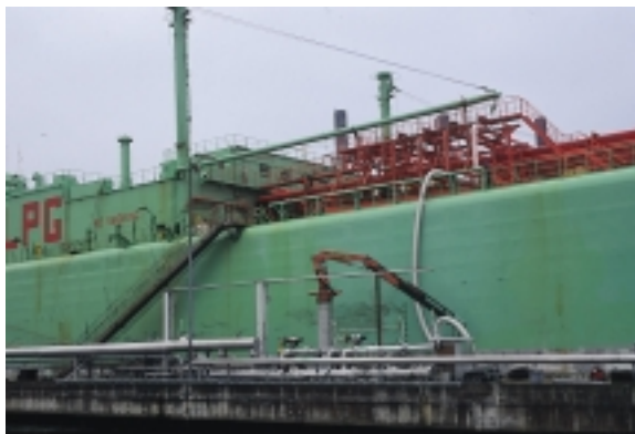
Lossning av gasol
