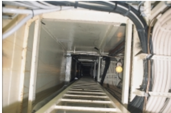
Nödutgångsschakt från maskinrum
