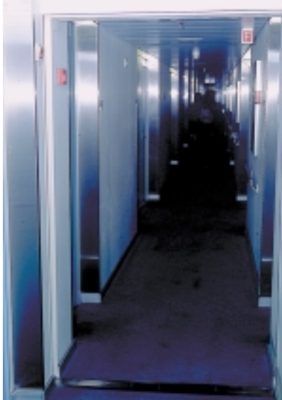
Automatiska branddörrar i korridor
