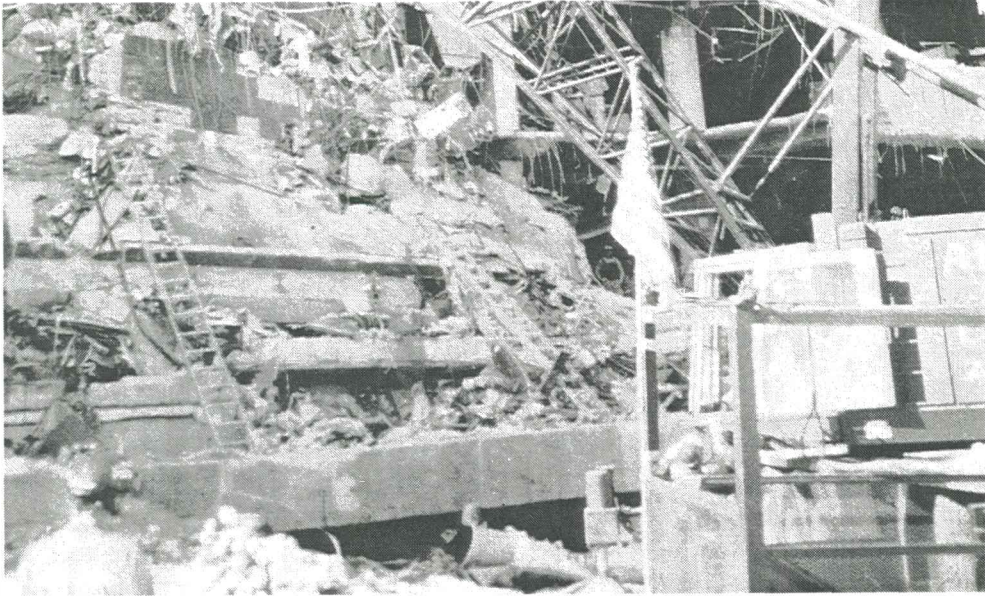
Bild 8/13. Förödelsen blev total, ca 1/3 avbyggnaden kollapsade. Explosionen orsakade en krater 10 m diameter och ca 2,5 m djup. (Foto Håkan Fehne, Västerås Räddningstjänst)
