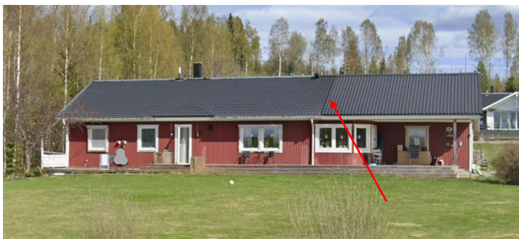
Figur 2. Den västra sidan på villan. På taket syns det tydligt var avskiljningen på vinden går (se röd pil) (bild: www.google.se/maps ).
