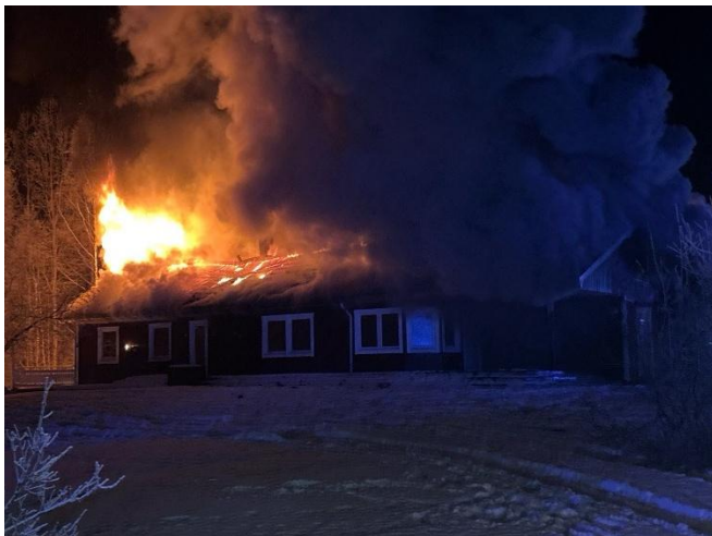
Figur 4. Bilden är tagen 21:46 och visar en genombränning av yttertaket vid norra gaveln (Bild: Daedalos Respons).
