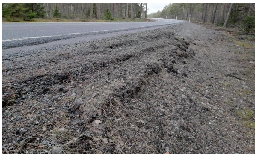
Figur 15: Slänten intill vägen där gastrailern gled ner. Bilden är tagen i riktning från där transporten kom körande.
