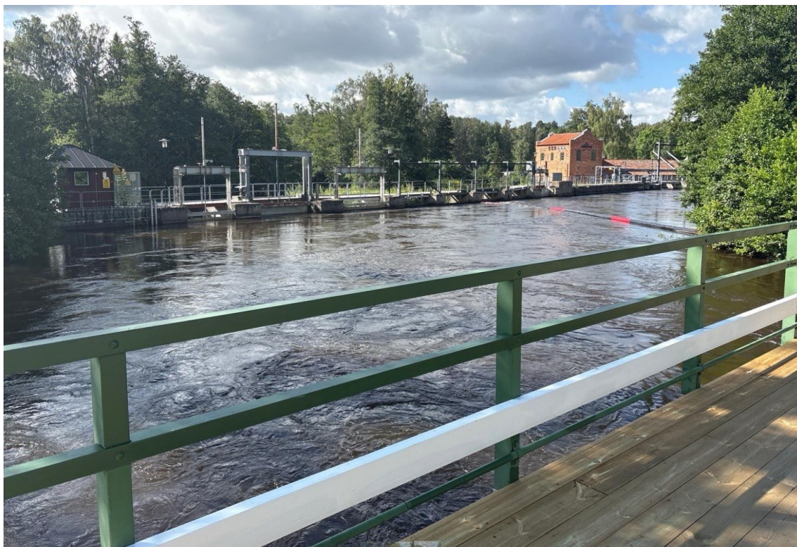
Bild 11: Foto taget av räddningstjänsten. Visar de starka strömmarna vid kraftstationen.
