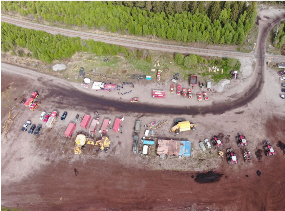
Figur 7 Bilden visar en överblick av ledningsplatsen. Källa Räddningstjänsten Halmstad.
