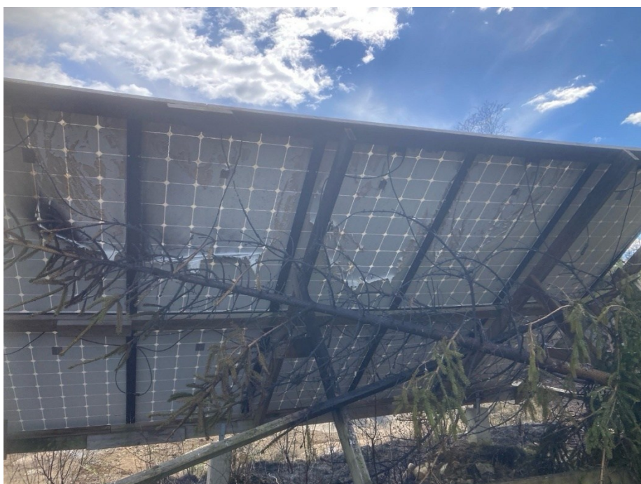
Figur 3. Solcellspanelens baksida med det infallna trädet. Källa: Räddningstjänsten Gislaved-Gnosjö.
