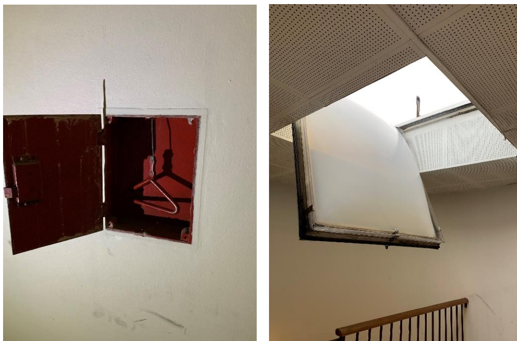
Figur 4. Till vänster: rök luckans manöverdon. Till höger: rök luckan i öppet läge. Foto SSBF:s utredare 2024-03-04.
