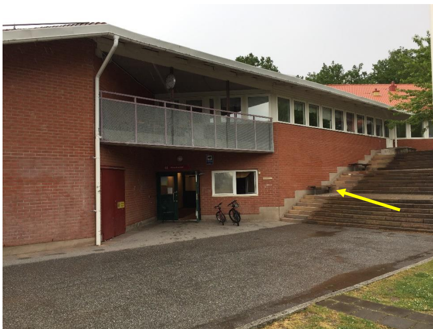
Bild 2. Fönster till brandutrymmet markerad.
