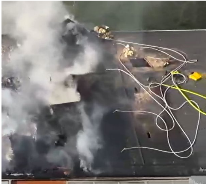
Figur 11 visar en bild över arbetet vid östlig begränsningslinje. Källa RSG.
