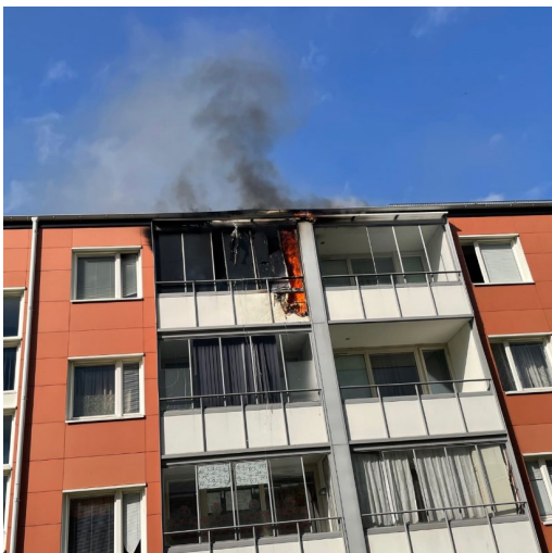
Figur 5 visar bild som är tagen 16:43 innan släckning. Källa RSG.
