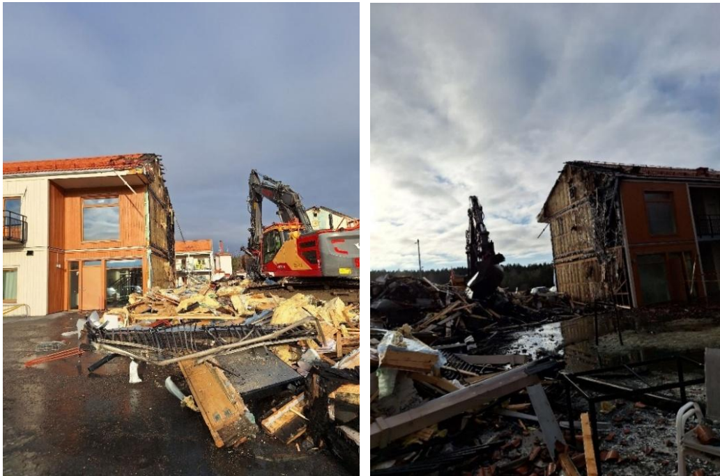
Figur 23. Bilden visar grävmaskin och rivning som gjorts mot huskropp 1 intill trapphuset, brun/orange fasad.
