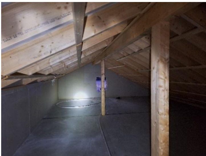
Figur 18. Bild från vindsutrymme ovanför lägenhet i huskropp 4 som är längst ifrån brandområdet. Rakt fram i bild går att urskilja byggnadens gavel där ett hål tas upp för att komma in på vinden.
