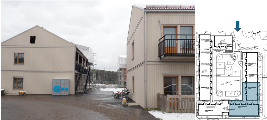
Figur 28. Från loftgången finns en utvändig trappa från huskropp 4 (till vänster i foto) samt från huskropp 3 (till höger i foto) som leder från andra våningen till innergården. Upp till vänster på byggnadens gavel syns hålet mot vinden som togs upp under räddningsinsatsen.
