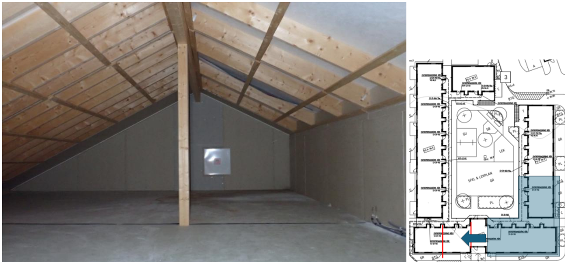
Figur 45. Vindsutrymme ovanför lägenhet i huskropp 1.
