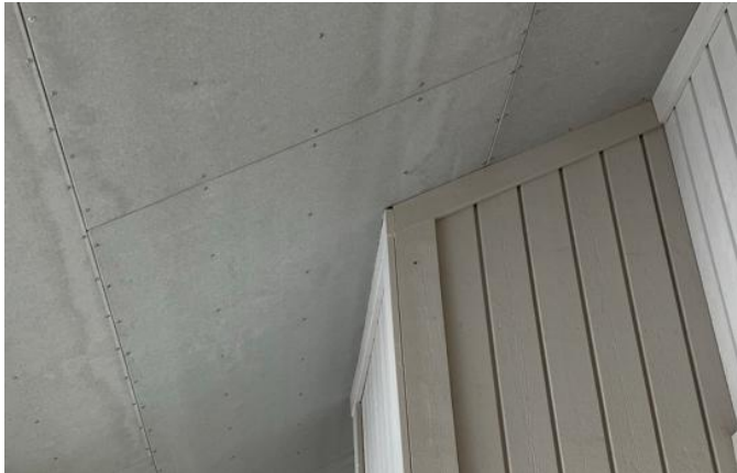
Figur 36. Schaktet i huskropp två, inom våningsplan två. I bilden syns schaktets utvändiga anslutning mot loftgångstak.
