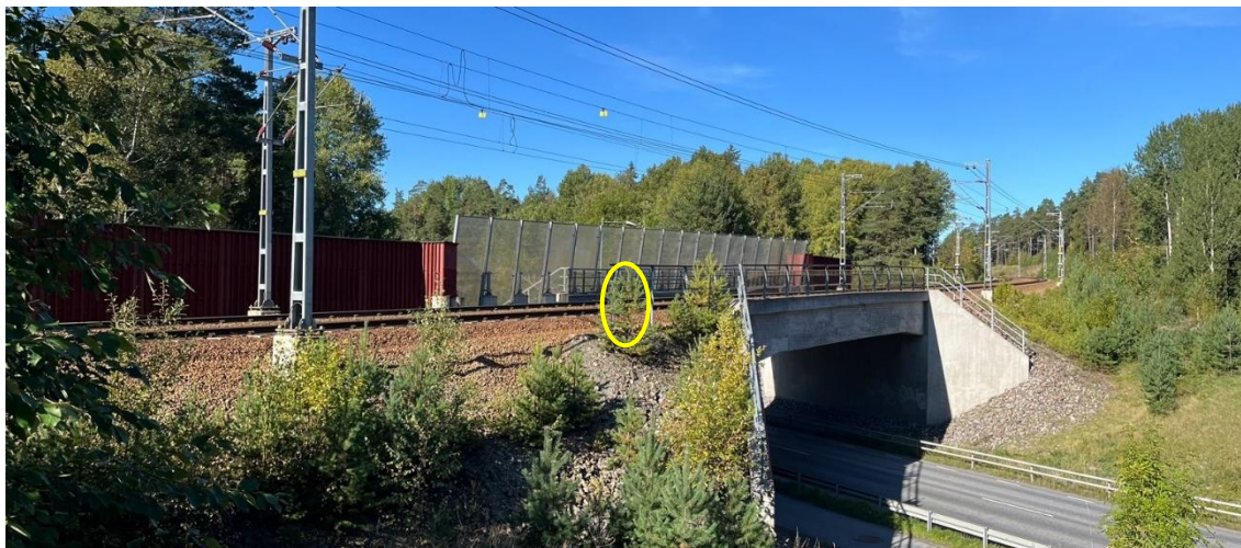
Figur 4. Broövergång för Bergtorpsvägen. Platsen där insatspersonal befann sig när södergående tåg passerar markering. Bild tagen av SSBF 2020-09-25.
