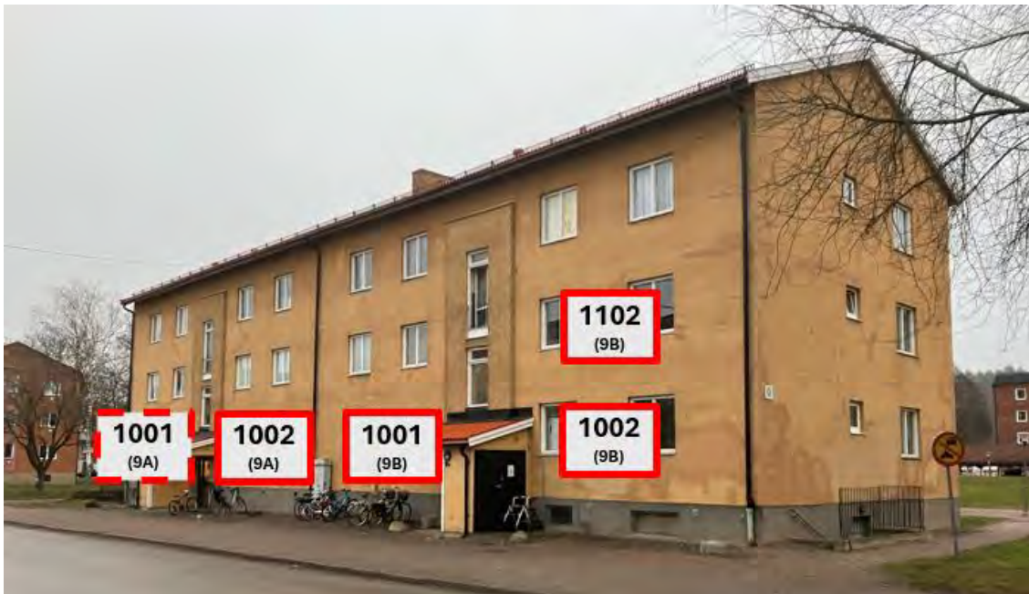
Sanerade lägenheter markerade med heldragen röd linje. Lägenhet markerad med streckad linje visar lägenhet som inte sanerades och som senare visade sig stå i förbindelse med källaren via öppen rörlits (foto: räddningstjänsten)
