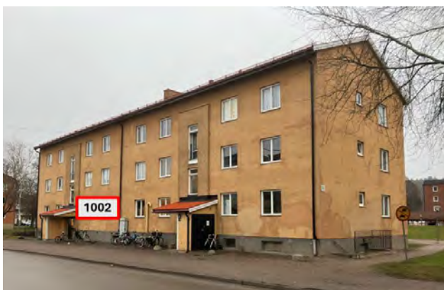
Lägenhet 1002, trapphus 9A (foto: räddningstjänsten)
