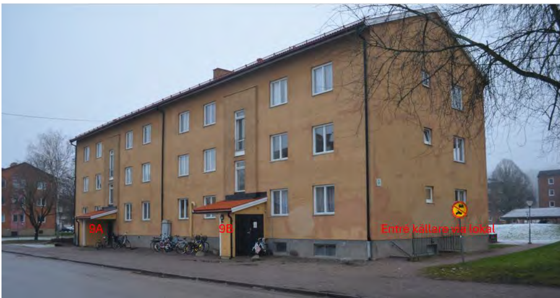
Byggnadens två portuppgångar och källardörr i västra gaveln (foto: räddningstjänsten)
