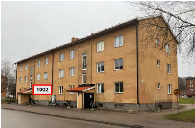
Lägenhet 1002, trapphus 9A (foto: räddningstjänsten)
