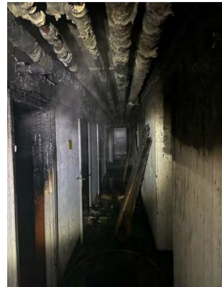
Källarkorridor, vy mot tvättstuga (foto räddningstjänsten)
