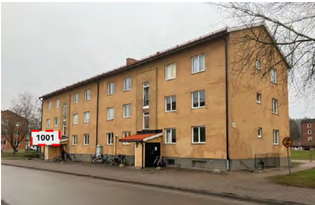
Lägenhet 1001, trapphus 9A (foto: räddningstjänsten)
