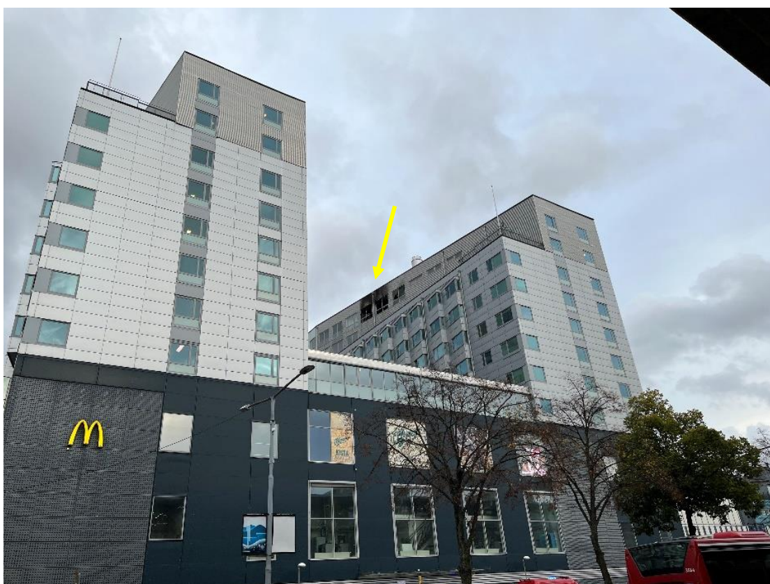
Figur 4. Brandlägenhet markerad. Bild tagen av utredaren från Danmarksgatan under insatsen.
