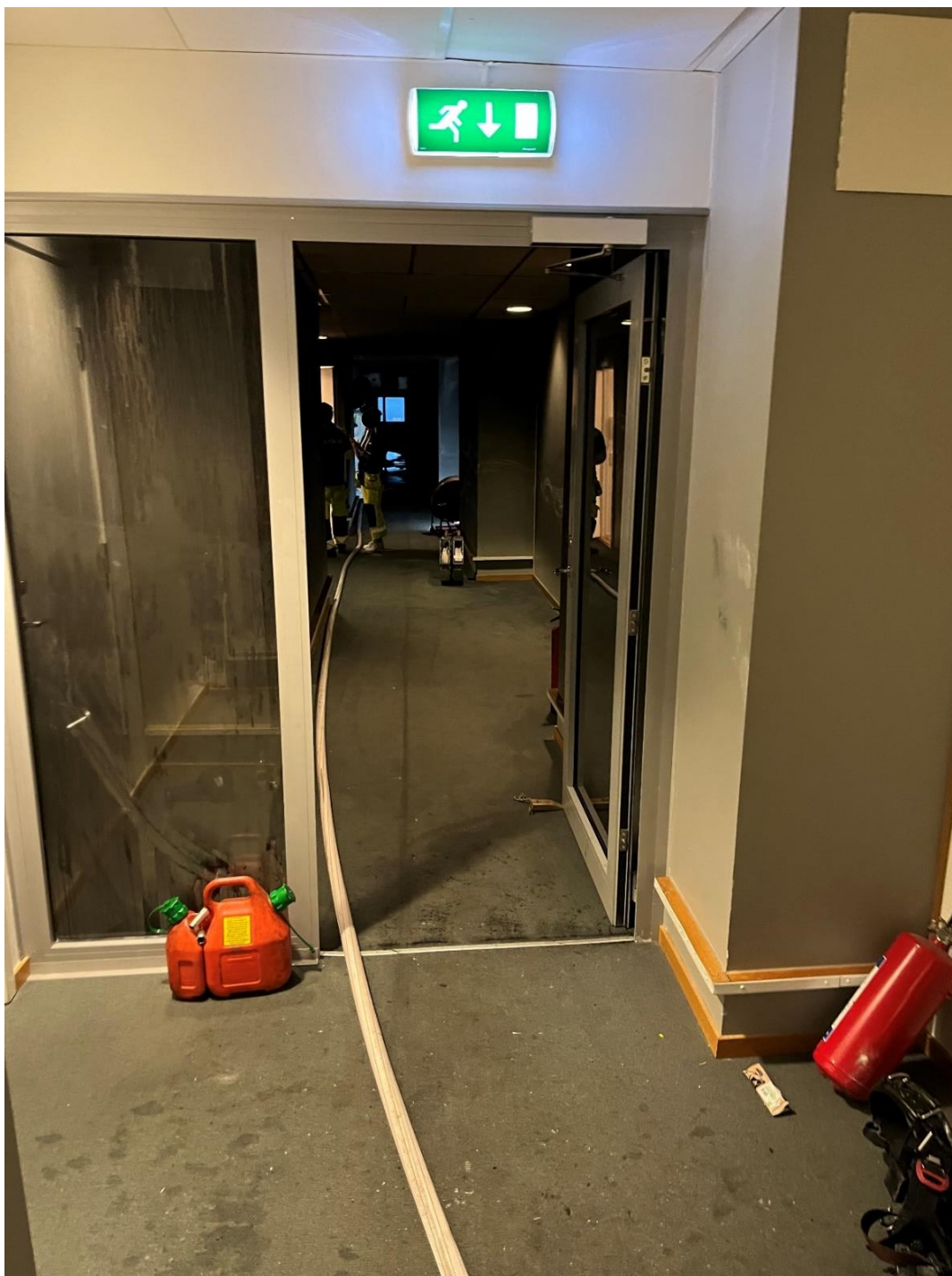
Figur 3. Brandavskiljande part mitt i korridor på plan 13. Bild tagen av insatspersonal under insatsen.
