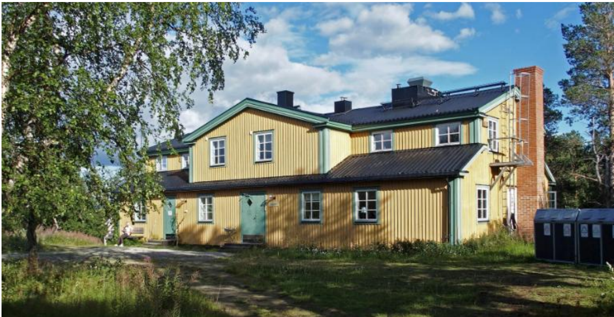
Figur 2 Bild på den branddrabbade byggnaden innan branden.
