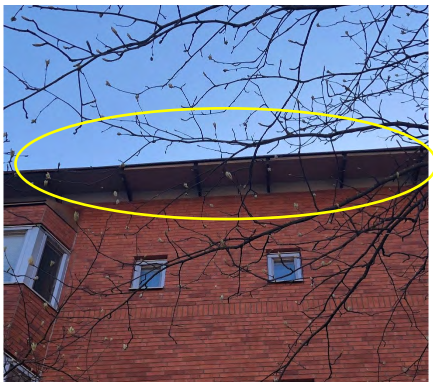
Figur 3 Obrännbara plattor uppsatta i takfot.
