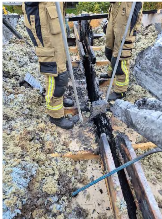
Figur 7. Arbete med dimspik mot gaveln vid den andra insatsen samt resultatet av branden i väggen.
