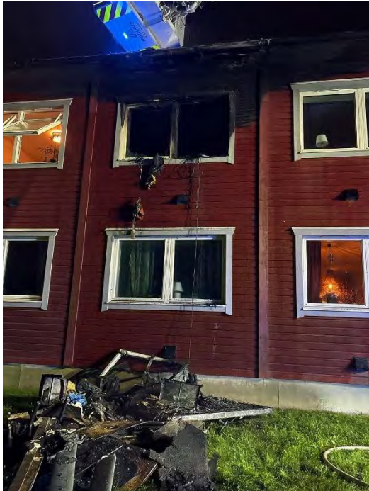
Figur 6. Omfattning på brandskador från den första branden.
