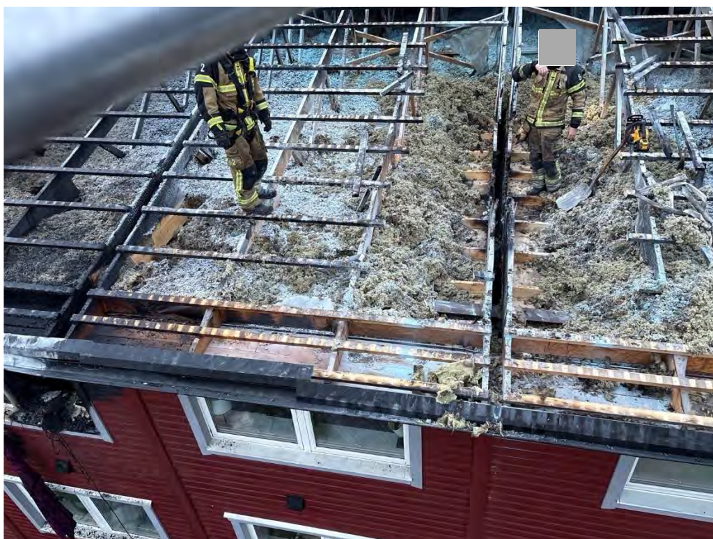
Figur 9. Bild som tydligt visar avstånd från startlägenhet till sekundärbranden i innervägen.
