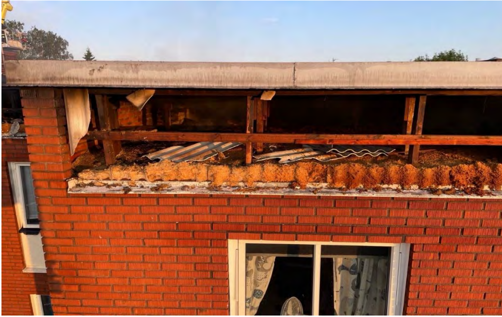
Figur 33. Bild på luftspalten samt isoleringsmaterial.
