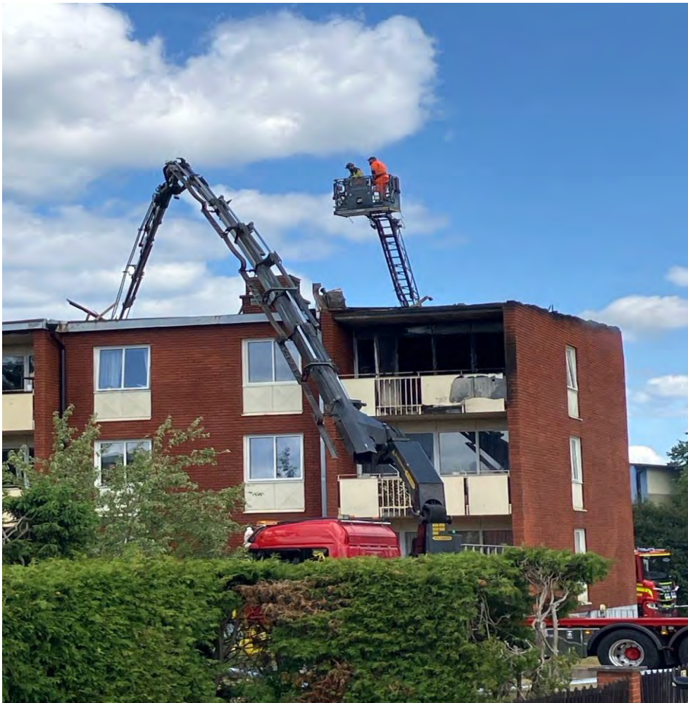
Figur 9 Arbeta på tak med borttagning av tak och solcellspaneler
