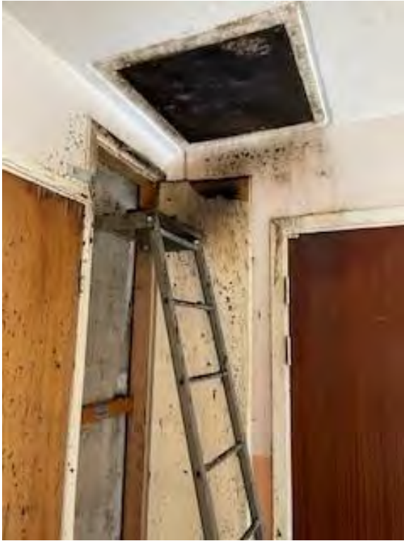
Figur 36. Vindslucka i trappuppgång C. Fotot togs 2025-07-09.
