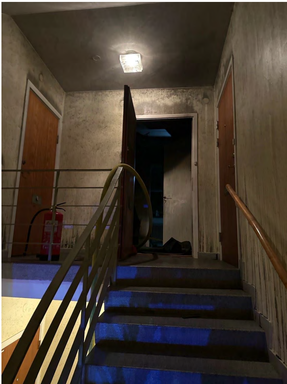
Figur 8 Rökpåverkat trapphus. I mitten syns dörren stå öppen intill brandlägenheten.
