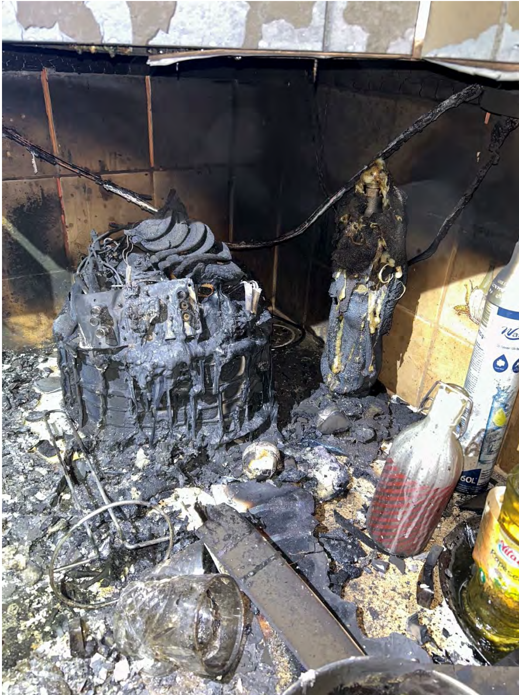
Figur 5 Bilden visar en brandskadad vitvara till höger om spisen. Troligen en airfryer eller riskokare.
