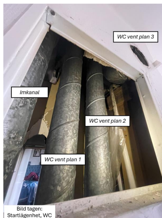
Figur 4. Ventilationsschakt.
