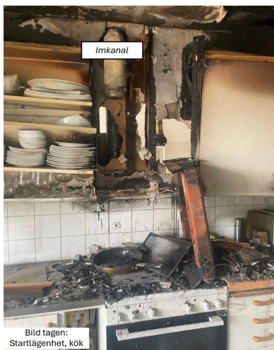
Figur 10. Brandens startplats och illustrerad spridning via imkanal.
