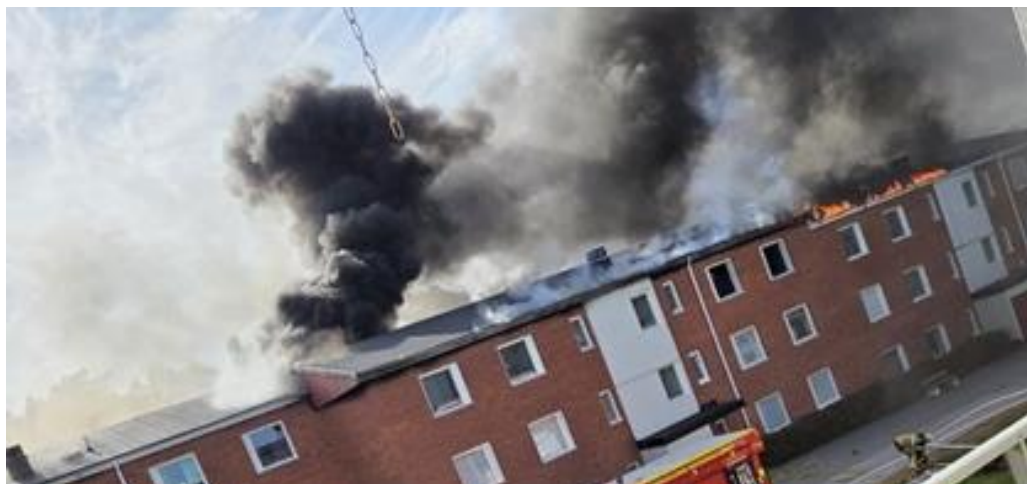
Figur 15. Bild under det tidiga brandförloppet där synliga lågor går ut genom takfot och rök trycker ut genom håligheter i taket.
