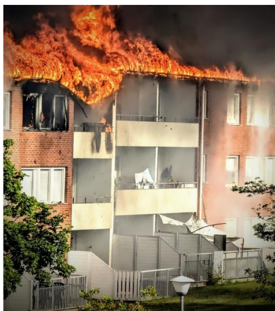
Figur 8. Baksidan av byggnaden när vinden brinner.
