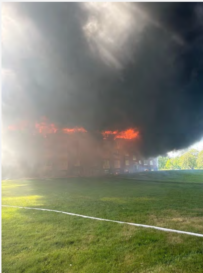
Bild 16. Klockan 14:07 vindförhållandena pressade brandröken nedåt.
