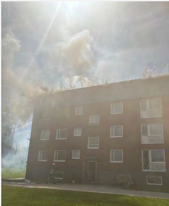
Bild 10. Klockan 13:38 rökspridning längs takfoten.
