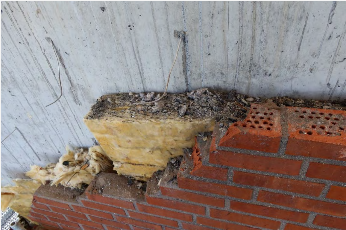
Bild 9. Inga brännbara byggnadsdelar i gavelfasaden.
