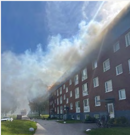
Bild 12. Klockan 13:39 kraftig rökutveckling på vinden.
