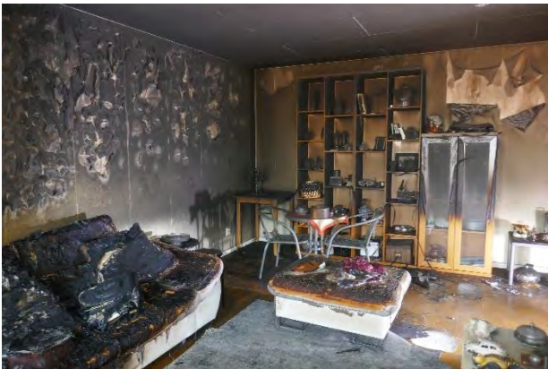
Figur 8 vardagsrummet, från fönster
