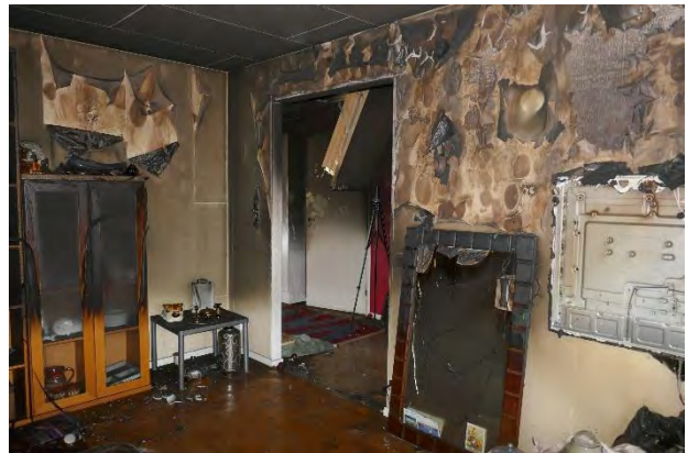
Figur 9 vardagsrum, mot hallen
