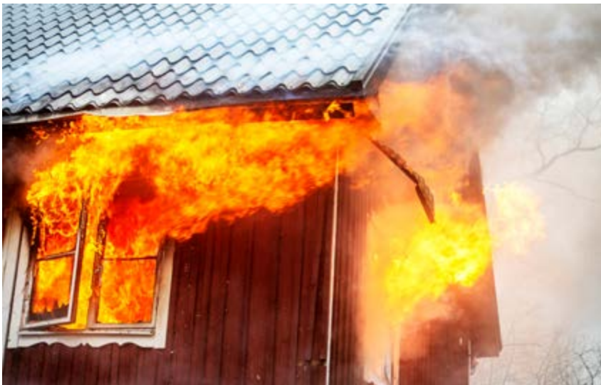
I praktiken påverkas graden av ventilationskontroll av hur många och hur stora öppningarna är till rummet där det brinner. Foto: Åsa Brorsson.
