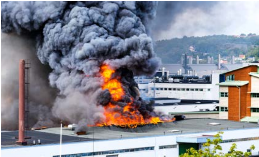
En brand i ett enskilt föremål kan fort växa och sprida sig till stora delar av eller hela byggnaden. Foto: Johnér Bildbyrå.
