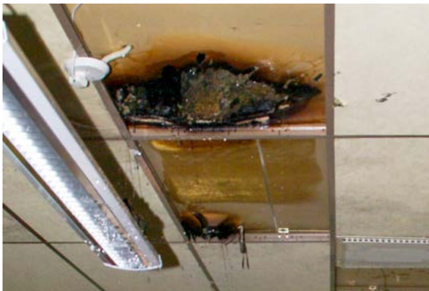
Bränder inne i konstruktioner kan sprida sig långa sträckor och orsaka stora skador. Foto: Stefan Svensson.
