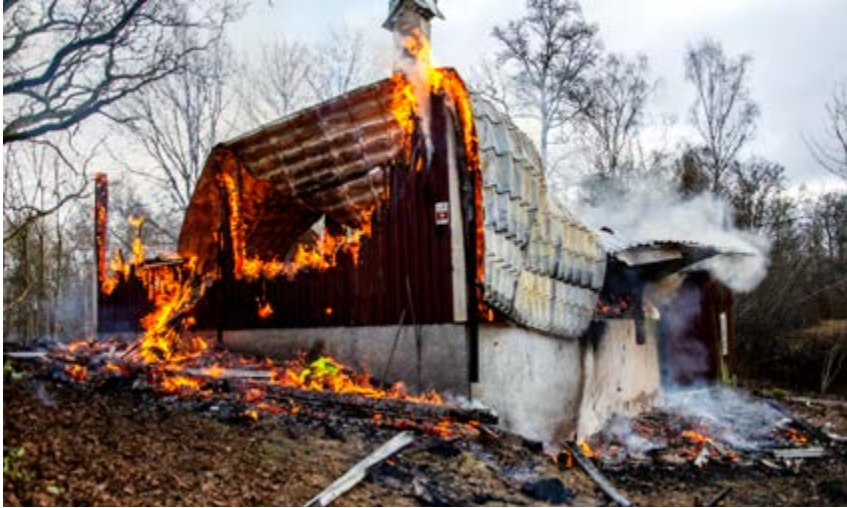
Ju längre branden får fortgå, desto större blir risken att byggnadens bärande delar kollapsar. Foto: Åsa Brorsson.
