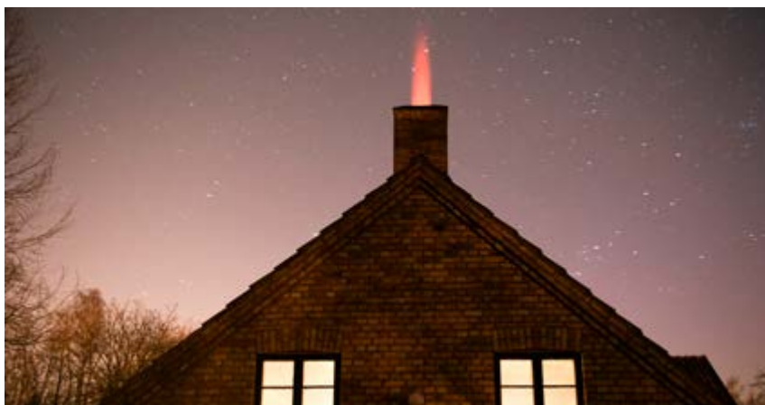
En soteld, dvs en brand i en skorsten, kan ge lågor som står upp högt över skorstenstoppen. Risken för spridning till byggnadens konstruktion är mycket stor. Foto: Johnér Bildbyrå.
