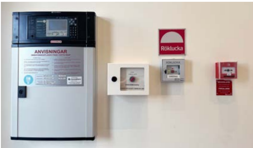
Ett av flera väsentliga tekniska egenskapskrav på byggnadsverk är säkerhet i händelse av brand. Foto: Stefan Svensson.
