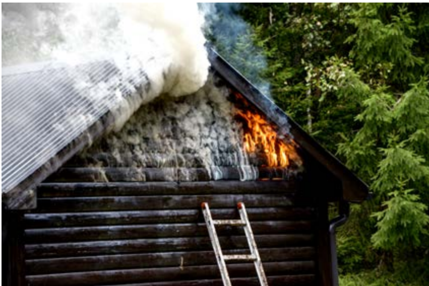
Brandförlopp i rum med begränsad ventilation. Foto: Åsa Brorsson.
