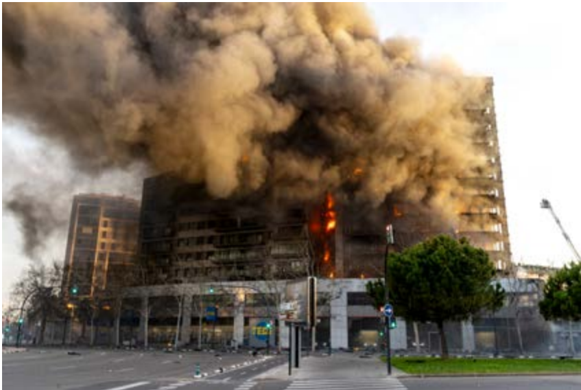
Fasadbränder kan innebära stora problem, på grund av snabb brandspridning. Foto: Johnér Bildbyrå.
