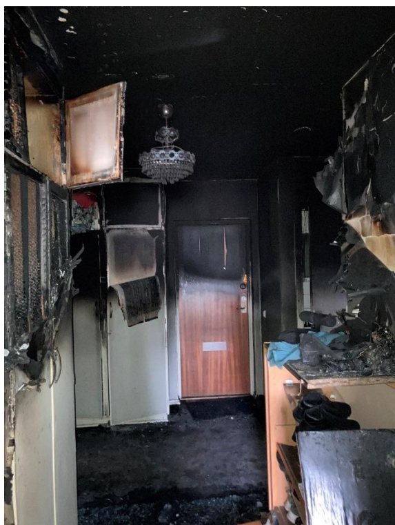
Figur 13. Hallen och lägenhetsdörren.
