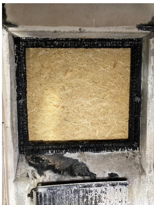
Figur 8. Insiida köksfönster närmast primärbranden. Observera hur det har kolat i karmen.
