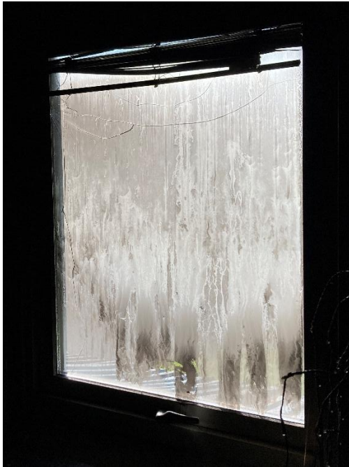
Figur 9. Sprucken ruta i vardagsrummet.
