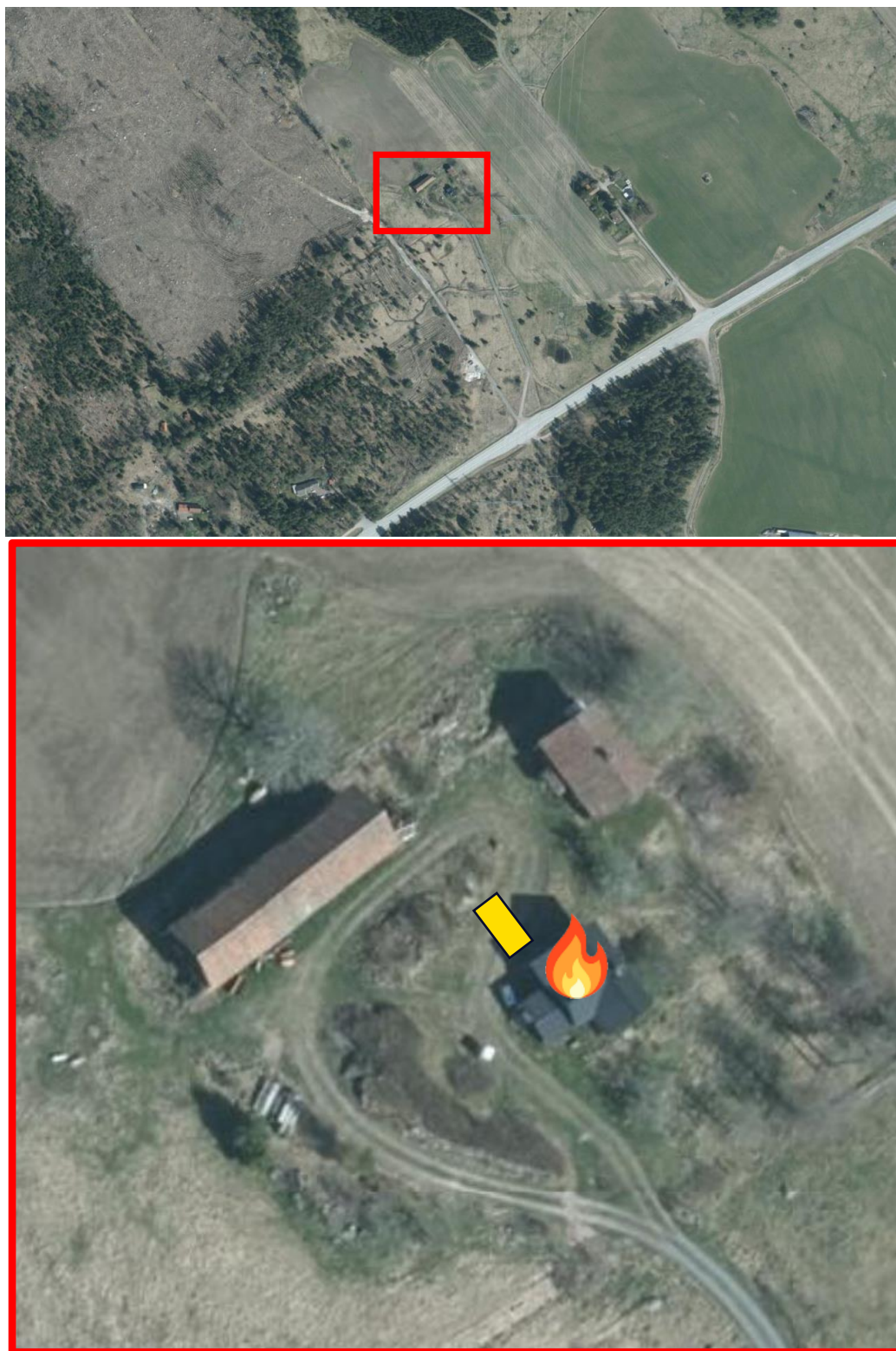
Figur 1 Flygfoto från brandförsvarets databas Daedalos 2025-03-13. Flamman visar huset som brann och gul rektangel visar ungefärlig placering av byggbarack vid tillfället för branden samt närliggande hus och lada.
