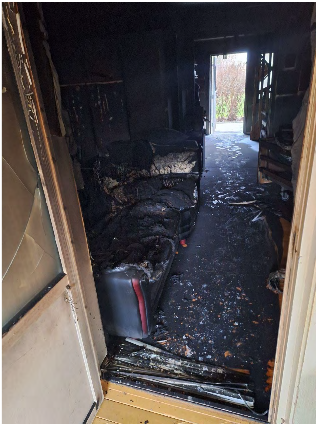
Figur 7 Soffan till vänster i bild och sängen (förflyttad), kan anas till höger i bild. Den har stått med huvudänden mot soffan och parallellt med väggen mot uterummet. Avstånd mellan säng och soffa är ca 90 cm (dörrens bredd). I bakgrunden syns ytterdörren som är öppen. Bilden är tagen från uterummet
