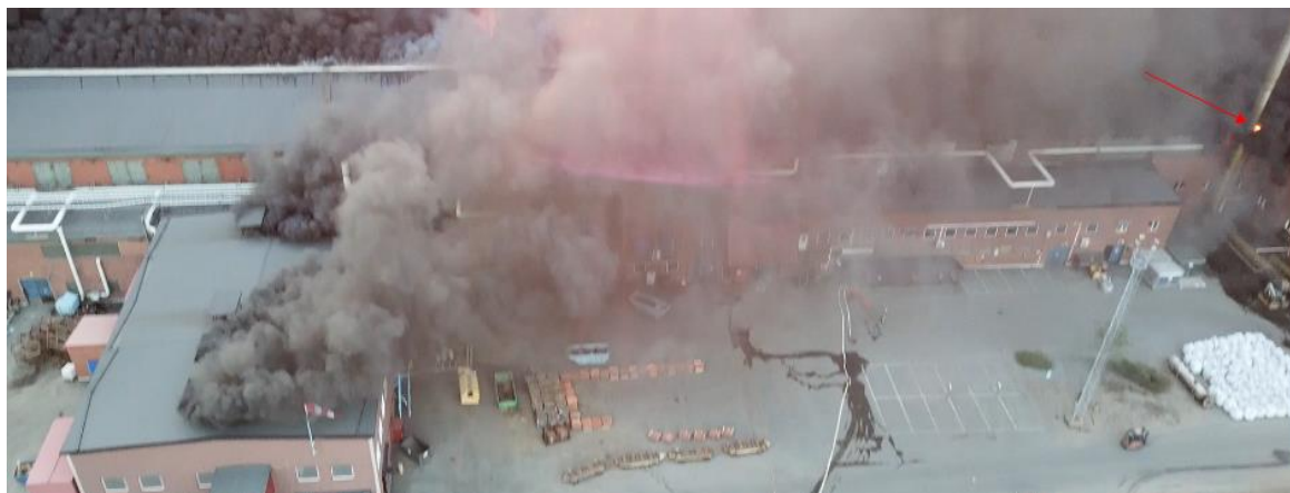
Figur 20: Skorsten som fattat eld. Skorstenen rasade senare. En bra riskbedömning medförde att området hade utrymmts och inga fordon eller personal fanns på plats.
