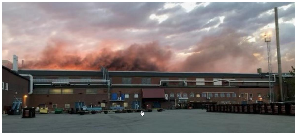
Figur 5: Läge vid framkomst 02.31, en del rök men inga synliga lågor utvändigt. Soluppgången gör att det ser ut som lågor vid taket.
