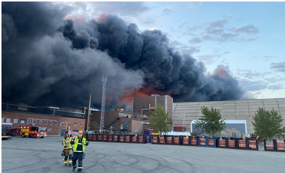
Figur 6: Lägesbild 02.43 endast 20 minuter efter larmet inkom till SOS. Även i denna bild är det soluppgången som gör att det ser ut som öppna lågor ovan tak. Endast kraftig rökutveckling än så länge utanför bygganden.
