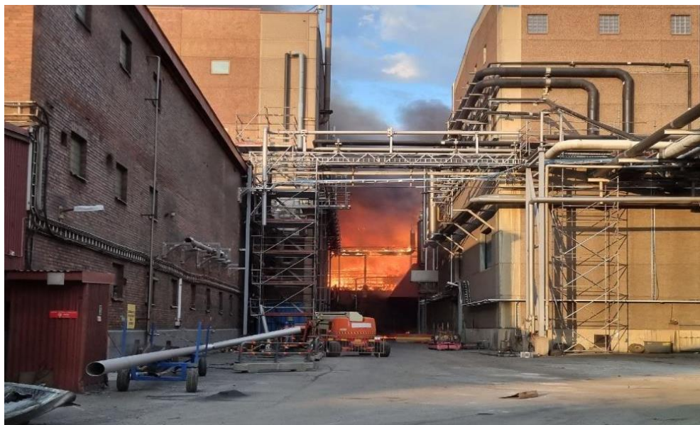
Figur 11: Korridoren med Konverterhallen till höger och Ädelmetallverket till vänster.
