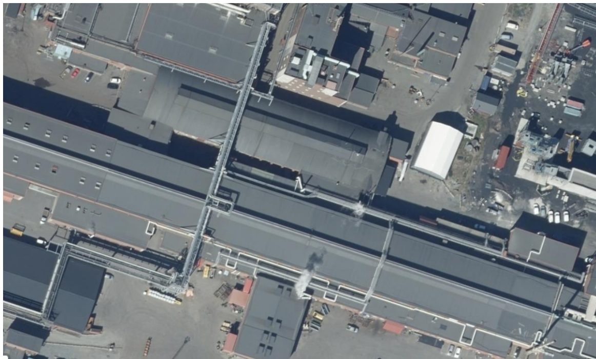
Figur 23: Rörbryggor för transport av olika medier t ex ammoniak, gasol och syrgas.
