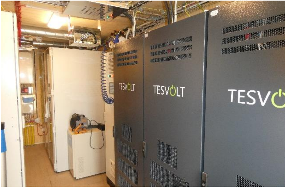
Figur 8: Containermodul med bränsleceller längst in och batterienergilagrar längst fram till höger.
