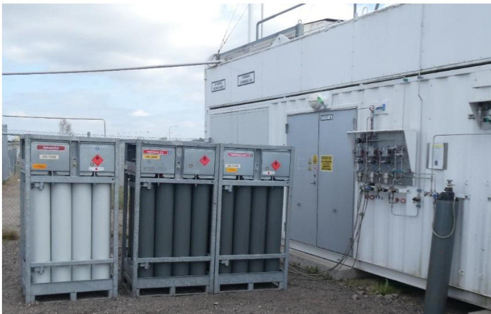
Figur 11: Vätgastankstationen med ett mindre vätgaslager i transportabla gasflaskor.
