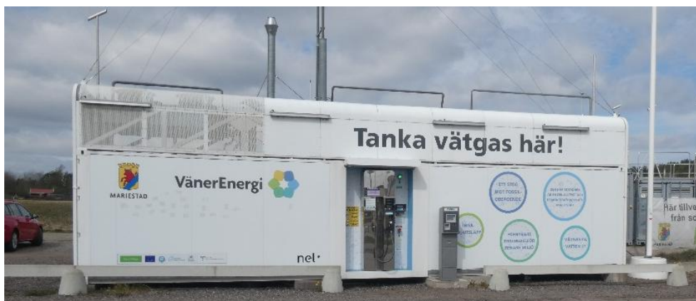
Figur 3: Container som innehåller vätgastankstationen.
