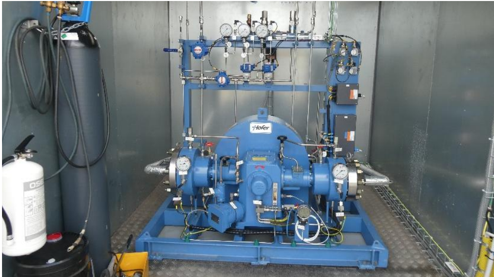
Figur 10: Kompressor i produktionsdelen som ökar trycket på vätgasen till 200 bar.
