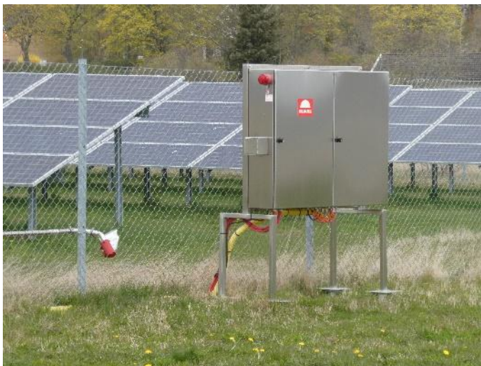
Figur 24: Centralapparat för brand- och gasalarm som var placerad cirka 30 m från produktionsdelen.
