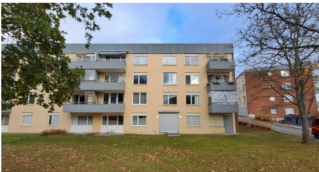
Figur 13: Bild tagen på byggnadens baksida.
