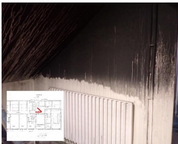
Figur 14: Bild i trapphuset i port 43 tagen i källaren.
