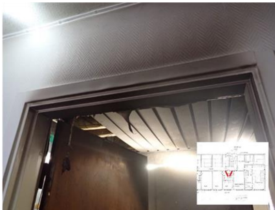
Figur 28: Bild på dörren in till lägenhet i port 43 på källarvåningen.
