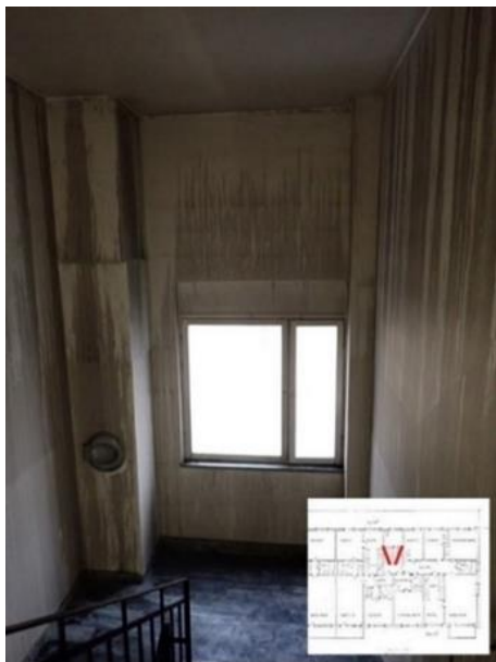
Figur 16: Bild i trapphuset i port 43 tagen från våning 3 (högst upp).
