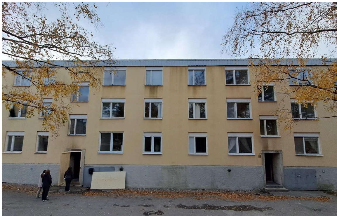
Figur 12: Bild tagen på byggnadens framsida. Till vänster syns port 43 och till höger port 41.
