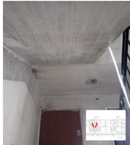
Figur 33: Bild i trapphuset i port 41 tagen från våning ett.
