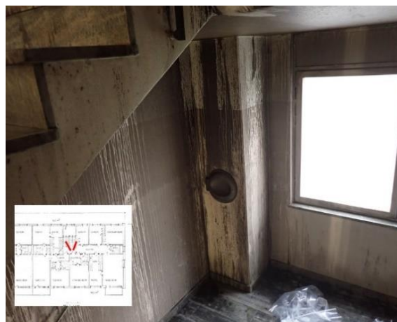
Figur 15: Bild i trapphuset i port 43 tagen från våning två.
