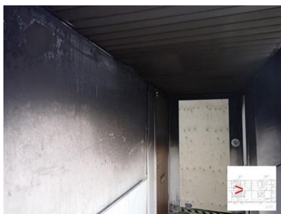
Figur 30: Bild i källaren i port 41 tagen i riktning mot källargången mellan port 41 och 39.
