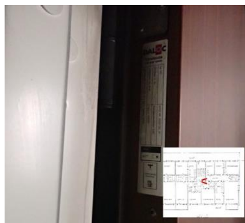
Figur 27: Bild tagen på en av dörrkarmarna in till lägenhet .
