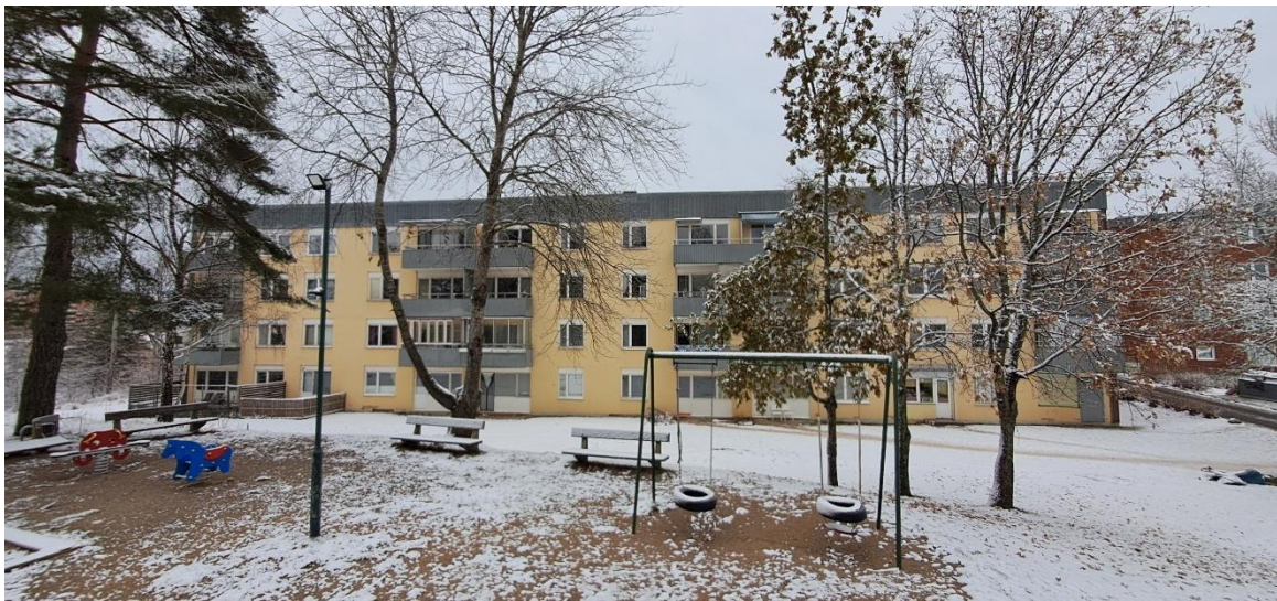
Figur 6: Bild på byggnadens sydvästra sida (baksidan).
