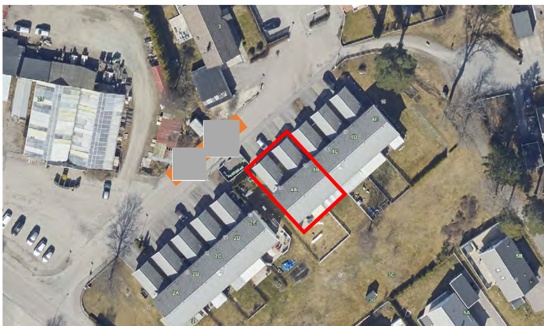
Bild 1: Översiktsbild [REDACTED] där inramad figur visar branddrabbad del av byggnaden innan branden.
