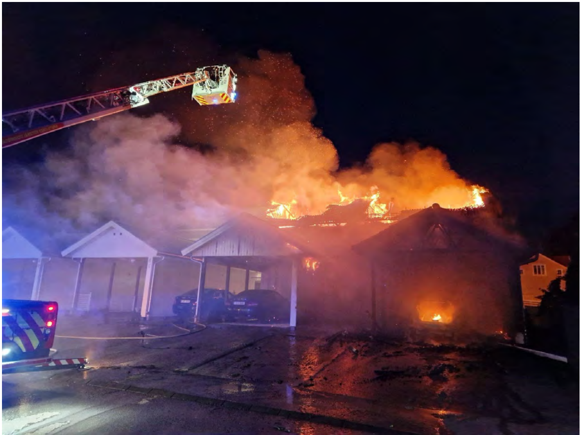
Bild 3: Branden har brutit igenom taken på 4A och 4B. Till höger i bild är carporten på 4A där branden startade.
