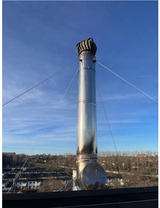
Figur 3 Rökkanalens utlopp (Skorstenstoppen).
