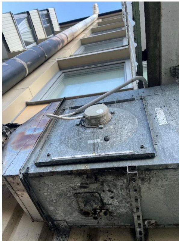
Figur 11 Rektangulär kanalfläkt, modell KT 60-35-4 SWO placerad på fasaden.
