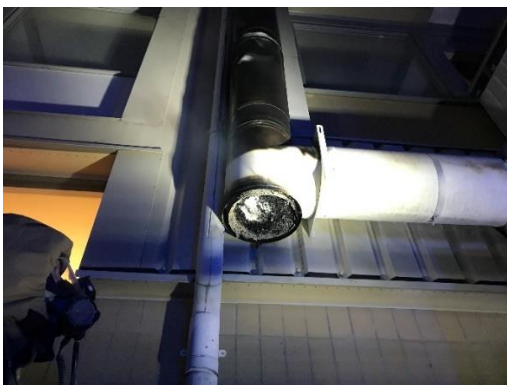
Figur 5 Rensning av blockering vid insats.
