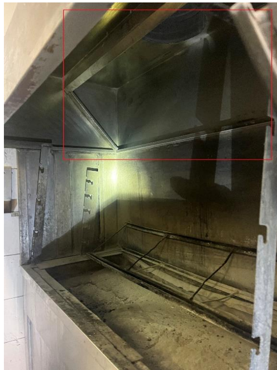
Figur 10 Den röda markeringen visar avsaknaden av gnistreducerade system.
