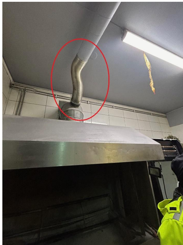
Figur 15 Markeringen visar frånluftsanslutningen på röckanalen.
