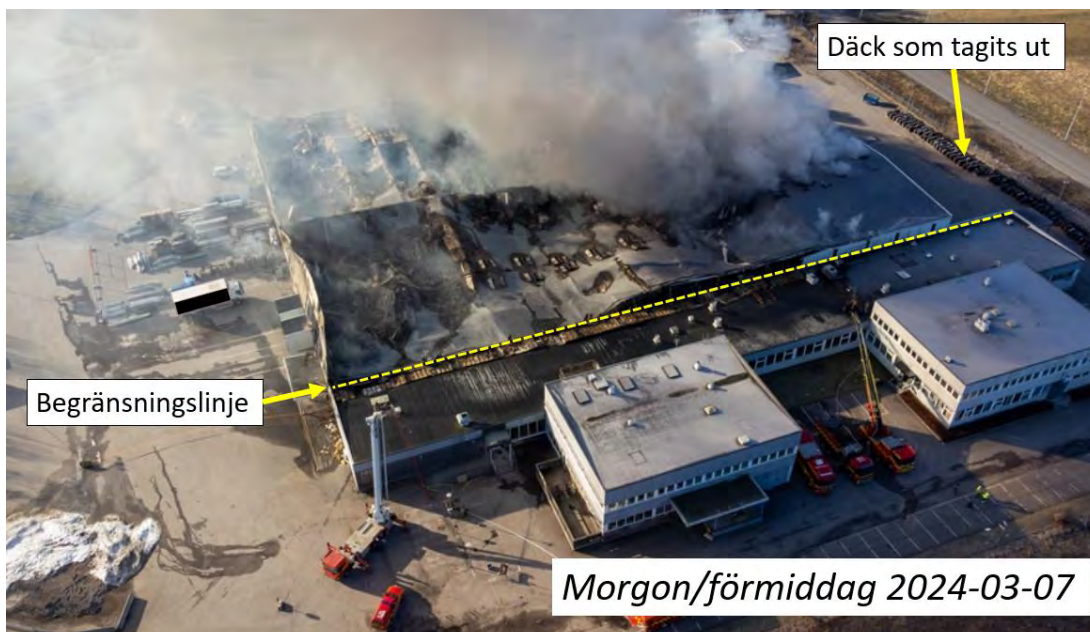
Figur 29 – Drönarfoto publicerat i media över byggnaden sedd från norra sidan, vissa tillägg gjorda i bilden. Foto från NT/Fredrik Nygren.
