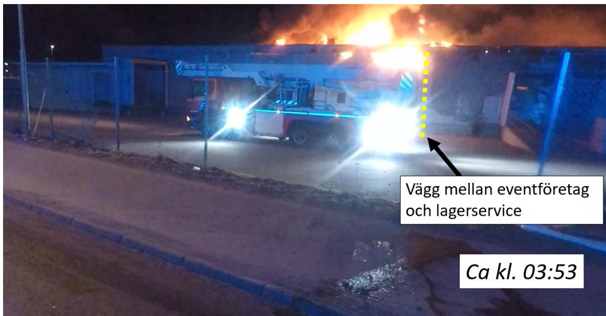
Figur 28 - Bildklipp hjälmkamerafilm cirka klockan 03:53. Omgruppering håller på att ske och hävare ska precis köras ut från området vid framsidan. Tydligt att spridning skett förbi tegelvägg mellan eventföretag och lagerserviceföretag.
