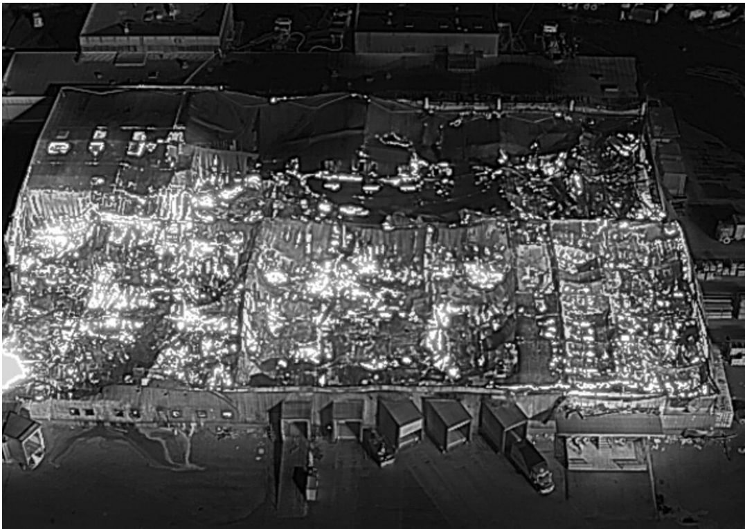
Figur 31 - Drönarfoto erhållet från polisen. Byggnaden sedd från södra sidan.
