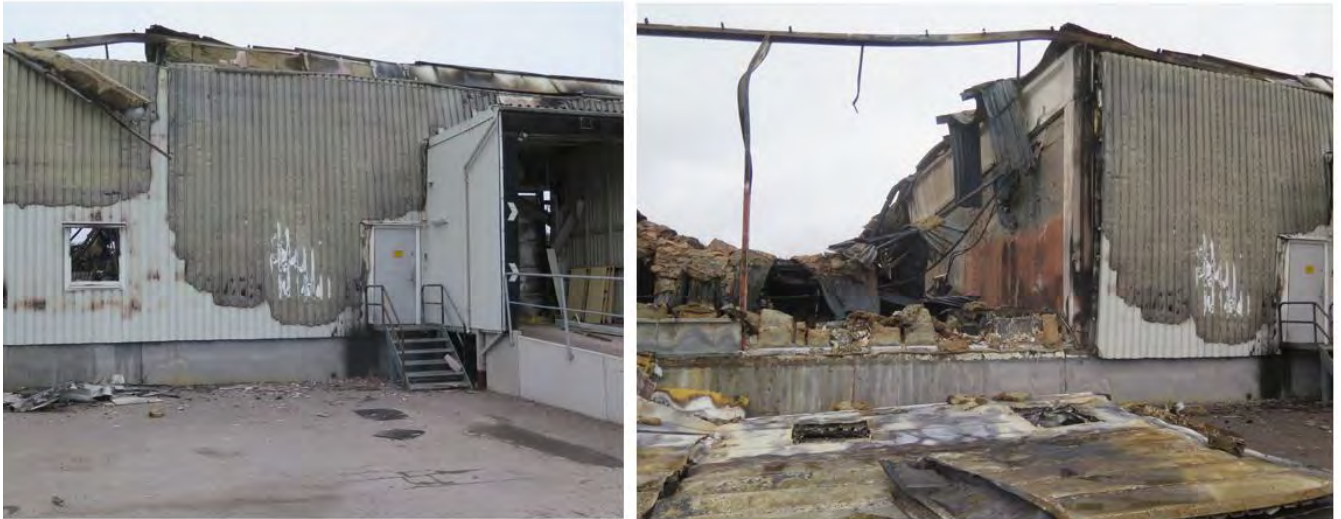
Figur 33 – Foto taget på framsidan vid platsbesök 240313 (t.v.) och platsundersökning 240321 (t.h.). Tegelväggskonstruktion mellan eventföretag och lagerserie är till synes intakt.
